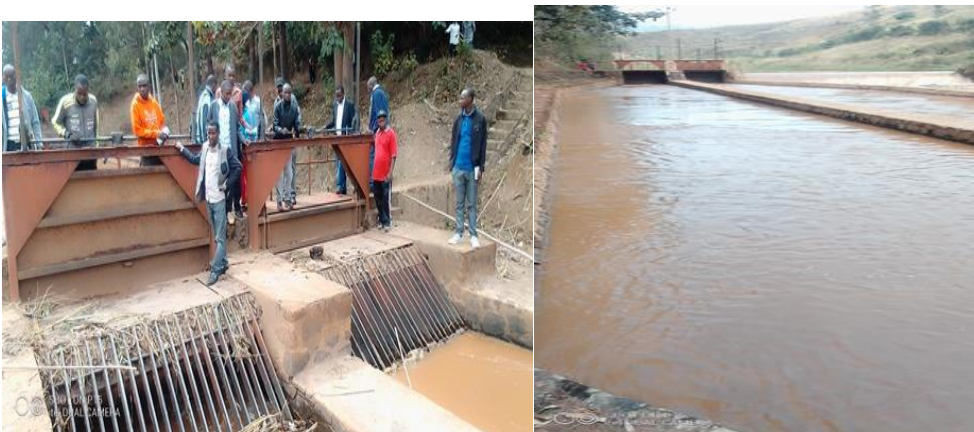
Photo 4: l'infrastructure de retenue d'eau sur la rivière RUVUBU qui alimente la centrale
